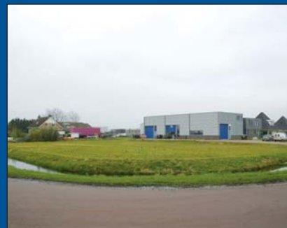
ANDIJK - Harde Grondweg 10
