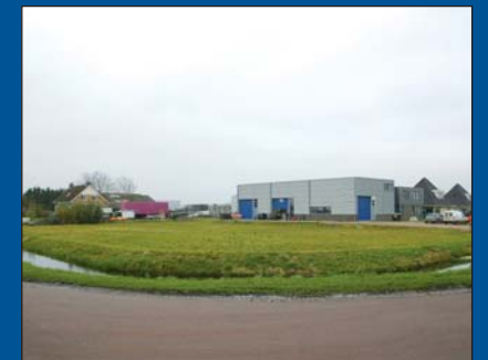
ANDIJK - Harde Grondweg 10
